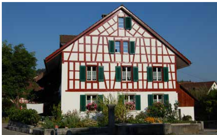
Markantes Riegelhaus an der Dorfstrasse 28.
