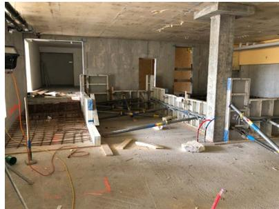
Der Höhenunterschied wird rollstuhlgängig betoniert.
